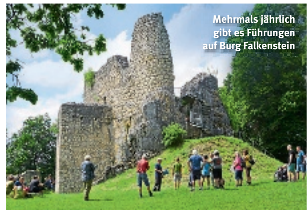
Die restaurierte Süd- wand der Schlossruine Hausen i. T. im Natur- park Obere Donau
